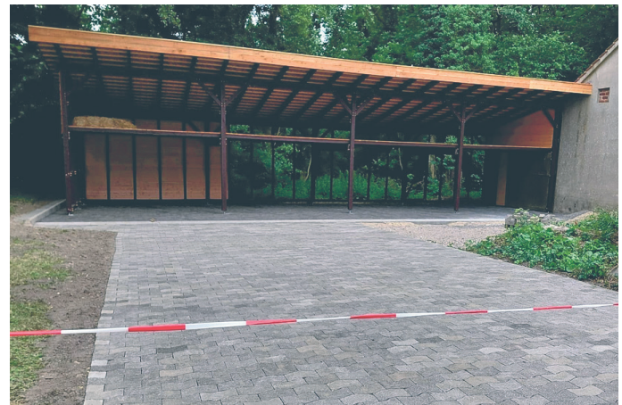
Die neue Wagenremise fügt sich harmonisch in das Ensemble des Heimathofes ein. Fotos: Privat
