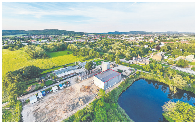
Luftaufnahme vom neuen, innovativen Heizkraftwerk und Wärmespeicher an der Ziegelstraße.
