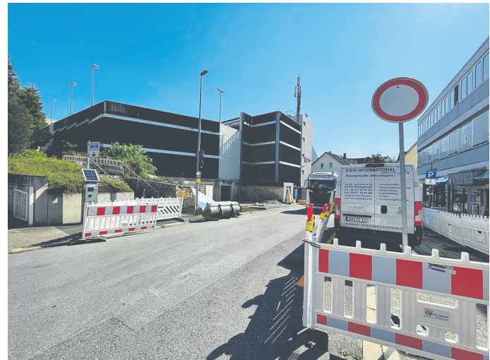
Die Baustelle am Parkhaus Altstadt schreitet voran.
