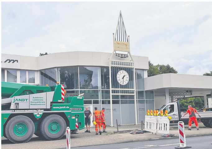
Der Abbau-Trupp vor ein paar Tagen. Der Turm soll jetzt in Detmold eine neue Heimat finden. Foto: Reiner Toppmöller
